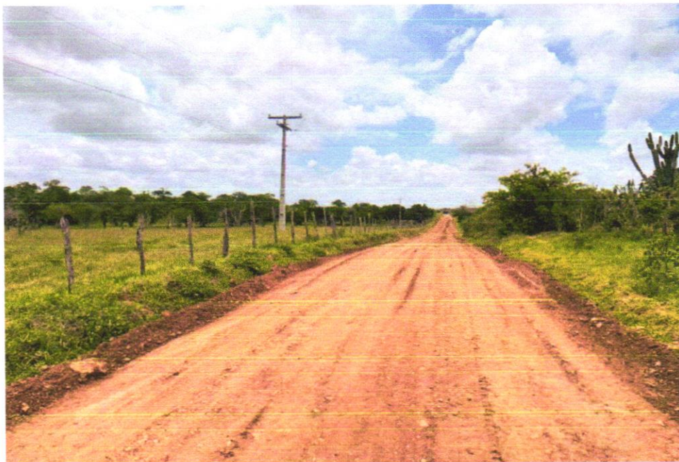
Foto 5 -EXECUÇÃO E COMPACTAÇÃO DE ATERRO COM SOLO PREDOMINANTEMENTE ARGILOSO - EXCLUSIVE SOLO, ESCAVAÇÃO, CARGA E TRANSPORTE. AF_11/2019
