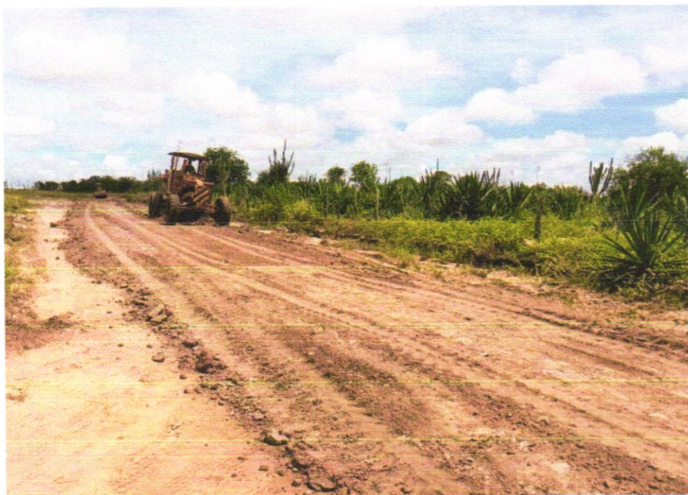
Foto 01 - REGULARIZAÇÃO DE SUPERFÍCIES COM MOTONIVELADORA
