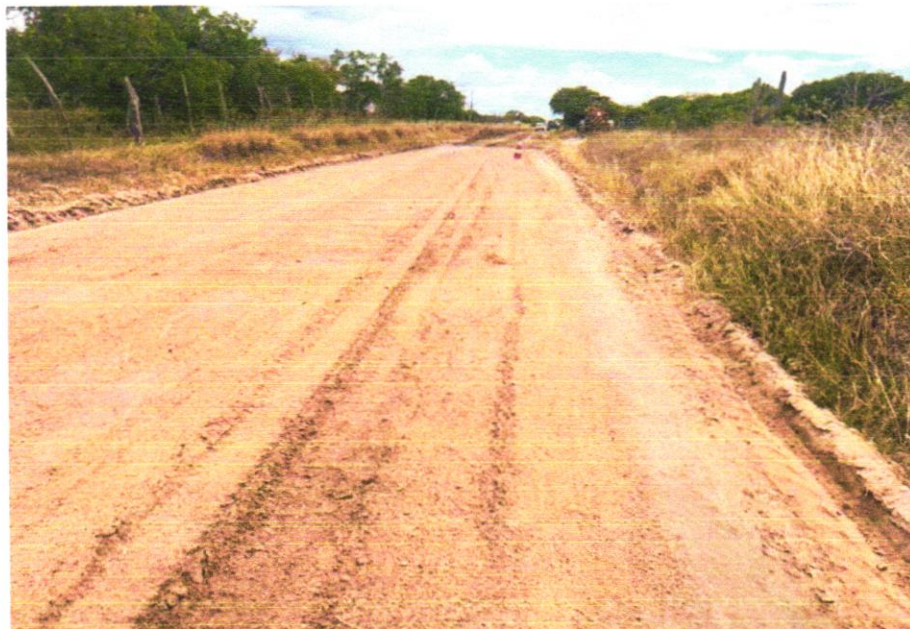
Foto 14 - EXECUÇÃO E COMPACTAÇÃO DE ATERRO COM SOLO PREDOMINANTEMENTE ARGILOSO - EXCLUSIVE SOLO, ESCAVAÇÃO, CARGA E TRANSPORTE. AF_11/2019
