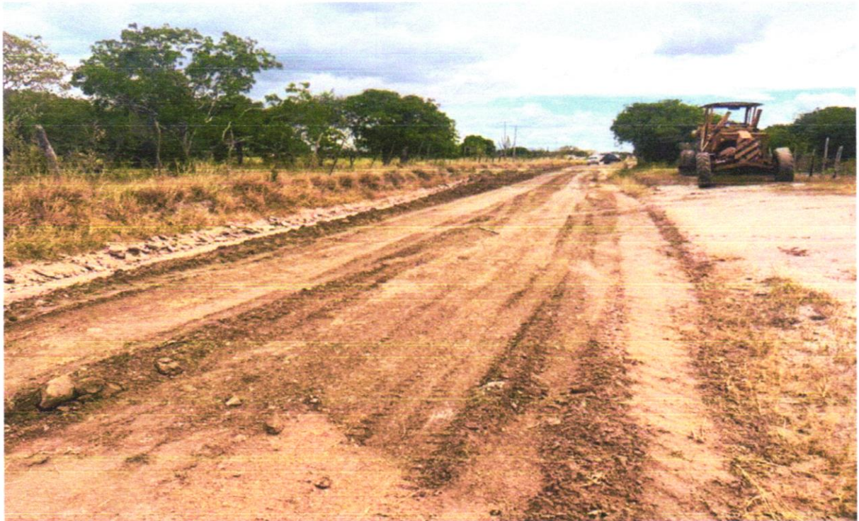
Foto 7 - ESPALHAMENTO DE MATERIAL COM TRATOR DE ESTEIRAS. AF_11/2019
