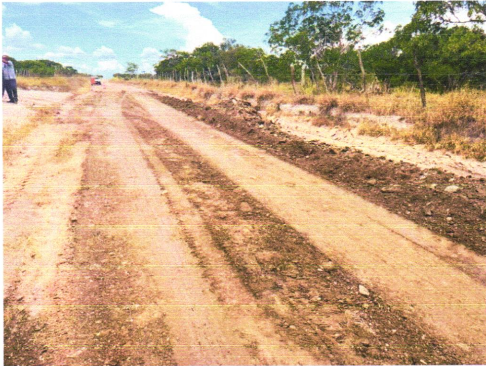
Foto 9 – ESPALHAMENTO DE MATERIAL COM TRATOR DE ESTEIRAS. AF_11/2019
