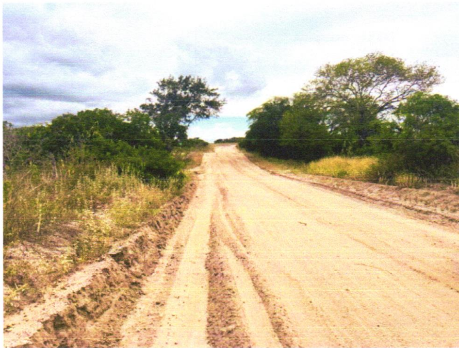
Foto 11 – EXECUÇÃO E COMPACTAÇÃO DE ATERRO COM SOLO PREDOMINANTEMENTE ARGILOSO - EXCLUSIVE SOLO, ESCAVAÇÃO, CARGA E TRANSPORTE. AF_11/2019
