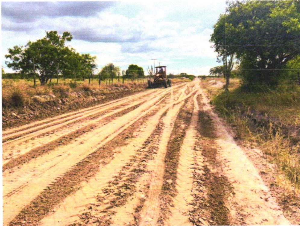
Foto 13 – ESPALHAMENTO DE MATERIAL COM TRATOR DE ESTEIRAS
